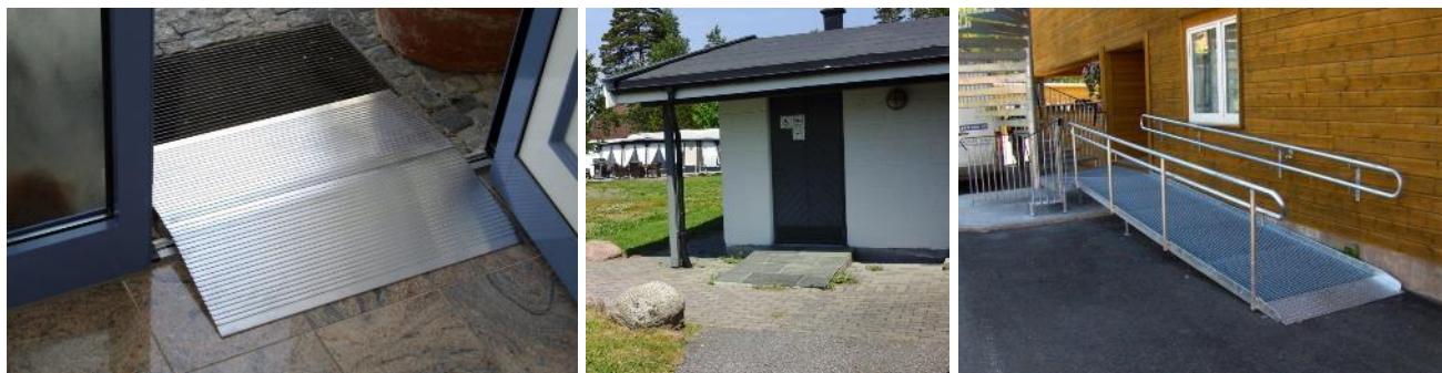
Figur 4: Terskelbro til venstre, skråningen (kartlegges som rampe) i midten og rampe på høyre.
