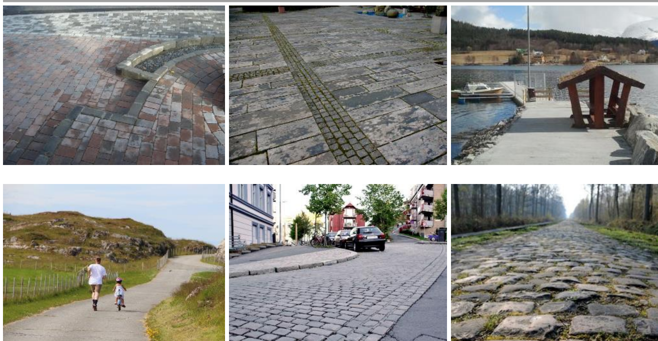
Figur 9: Eksempler på forskjellige underlagstyper (fra øverst mot venstre til nederst mot høyre) – Stein, blanding av stein og brostein, hvor stein utgjør hoveddelen av veien, gjennomgående betongdekke og betongplater, brosteindekke som er tilgjengelig og brosteindekke som ikke er tilgjengelig.
