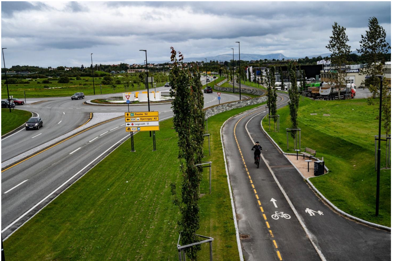
Foto. Bård Asle Nordbø – Statens vegvesen
